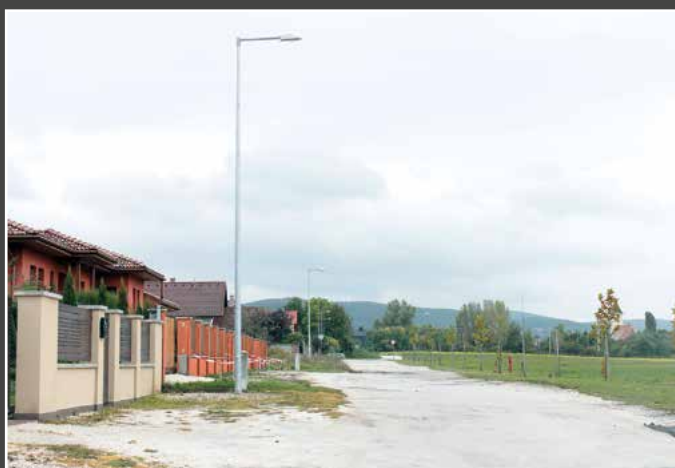
Északi lakóközvet közvilágítás-fejlesztés
